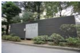
防災倉庫（9号館前）
