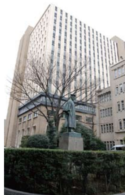
大隈銅像付近からの11号館
