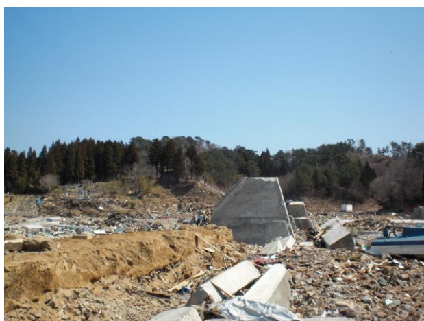
図 13：田老地区で壊れた防潮堤の残骸
