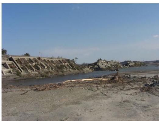
図 14：磯部地区の海岸護岸の崩壊
