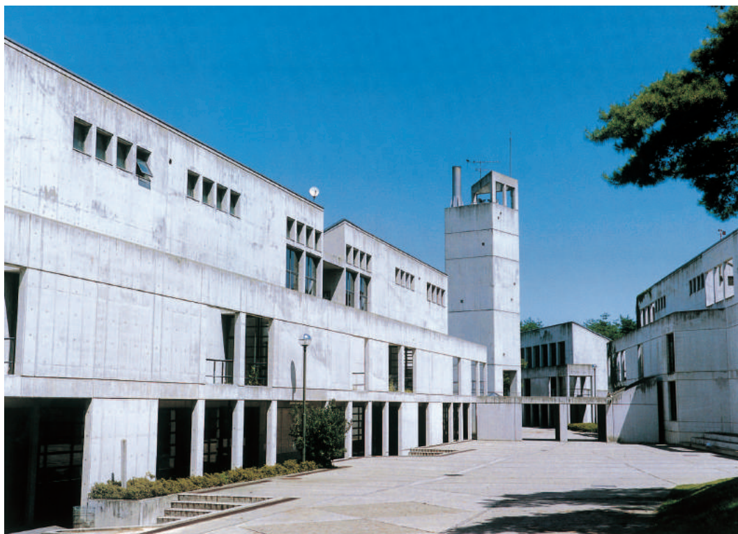
中庭（B棟・給水棟を眺む 提供：西沢写真館）
