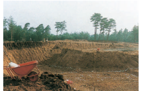
校舎建設地の造成開始（1981年）
