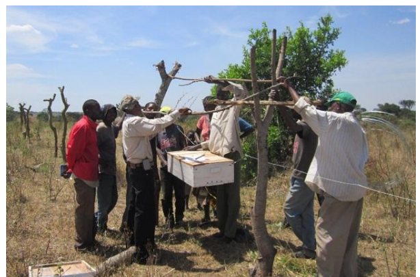
力を合わせて設置作業。草を刈り払い、ポールを立てて、ワイヤーを張る。かなりの重労働。
