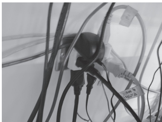
図 3 - 5 - 1. コンセントに直接挿したタップによるタコ足配線
