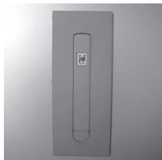
図1-4-11. 排煙窓の開放スイッチ
