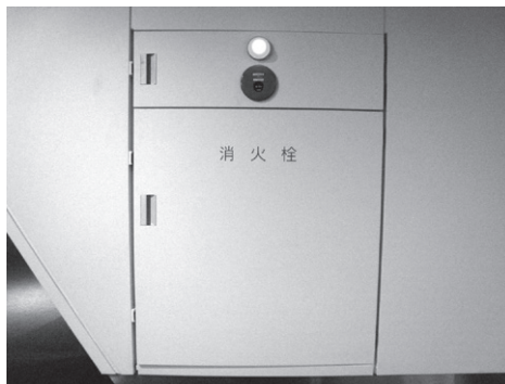
図1-4-2. 屋内消火栓の設置例
