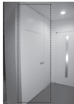
図1-4-4. 火災報知機の作動により閉 じる防火扉（大）（小）
