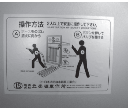
図1-4-3. 屋内消火栓の操作方法
