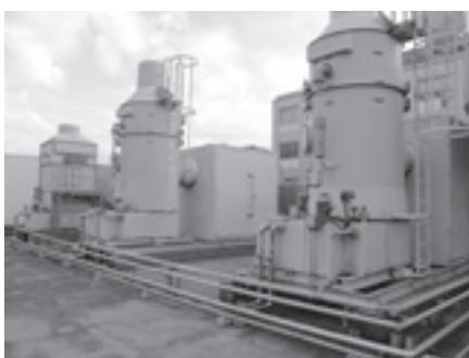
図3-3-8. スクラバー設備例
