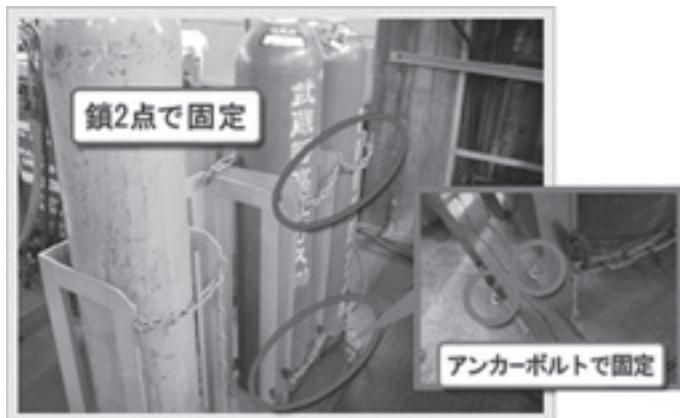
図3-4-5. 高圧ガス容器の固定
