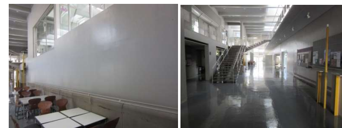
100 号館 A 棟（A2s 入口から入った廊下両側）
