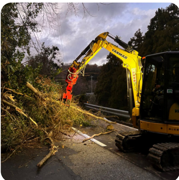
道路啓開の様子
