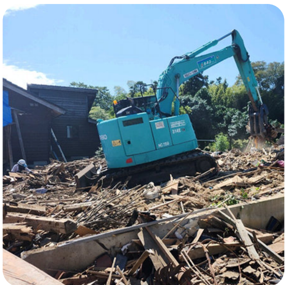
解体作業の様子
