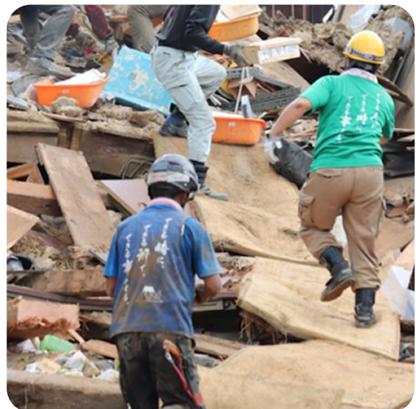
公費解体を行う家屋から貴重品を 搬出する作業の様子
