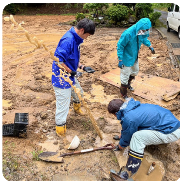
漏水修理の様子
