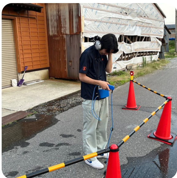
漏水調査の様子
