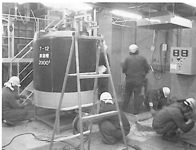
処理施設撤去工事
