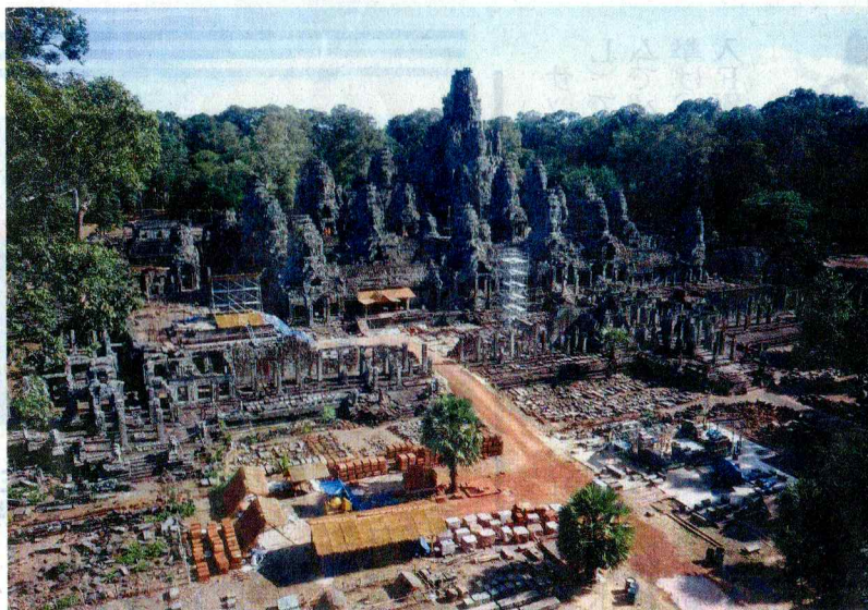
バイヨンの修復現場の様子(写真提供・JSA)
