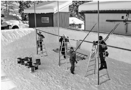
図6 運び出しが終わる前から単管パイプの組み上げ を始める (2018年2月14日, 筆者撮影)
