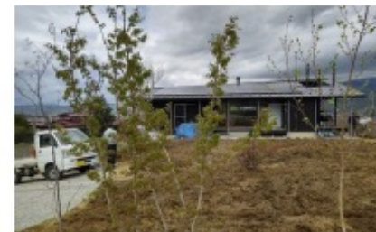
金山デッキでは植栽工事が始まっている＝2022年5月
