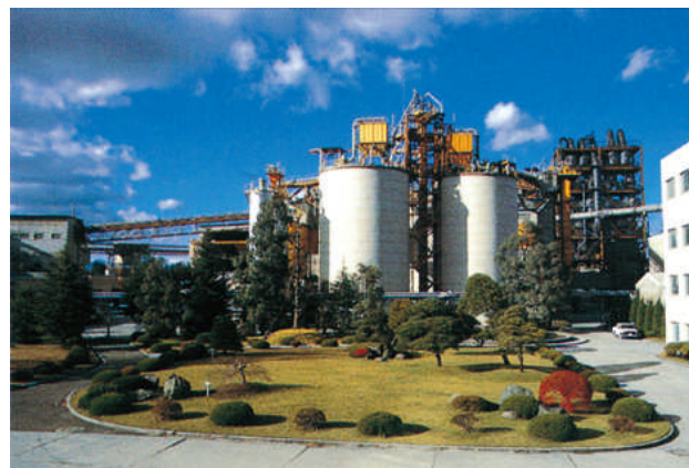
緑化の進んだ工場内
