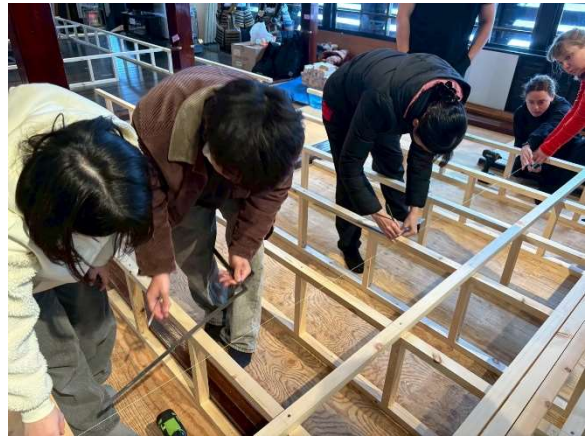
Fig. 2-3-6 下地組み作業
