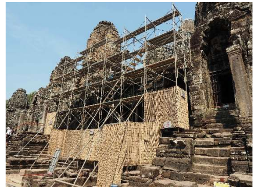
Fig. 4 塔 25-26 間回廊の作業現場
