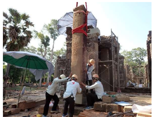
Fig.2 塔69整備作業の様子
