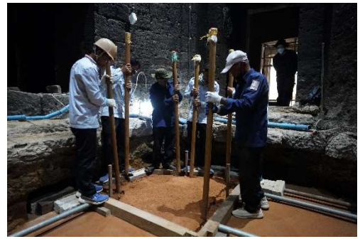
Fig. 3 埋戻し作業
