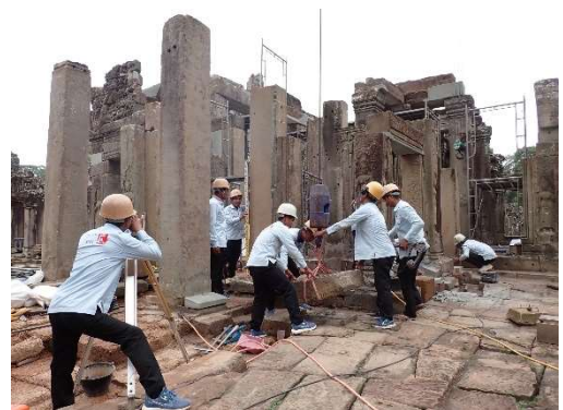
Fig.2 塔69 整備作業の様子
