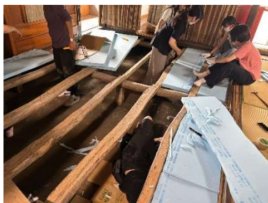
fig7. 既存床の撤去
