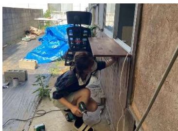
fig10. カウンターの設置
