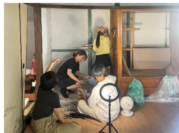
fig11. 押し入れと洋服簀笥の土壁を漆喰にて補修
