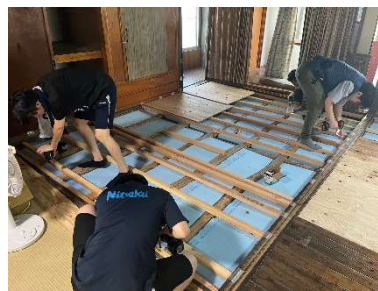
fig8. 床の構造補強と張替え
