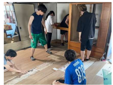
fig9. 押し入れと簀笥の解体
