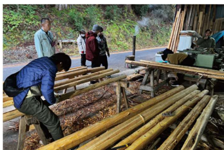
fig13. 間伐材の皮剥作業
