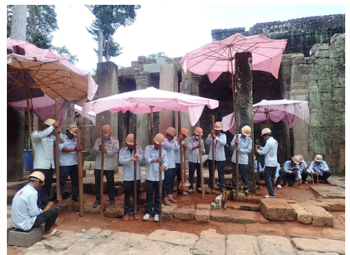
Fig.2 塔69 整備作業の様子
