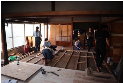
fig6. 床の張り替え作業
