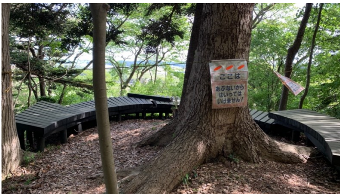
fig.2 補修工事前のデッキの様子
