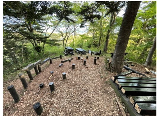
fig.3 補修のため一度デッキ材を外した際の様子
