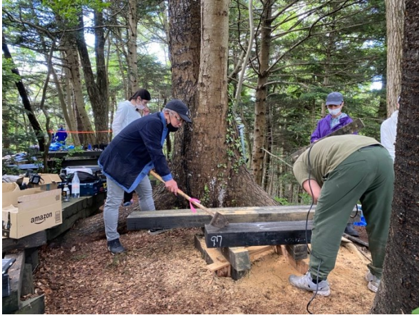
fig.4 補修工事の様子
