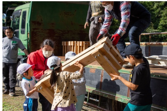
fig.19 完成したベンチを運搬している様子
