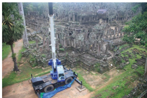
Fig.2 塔69周辺の様子
