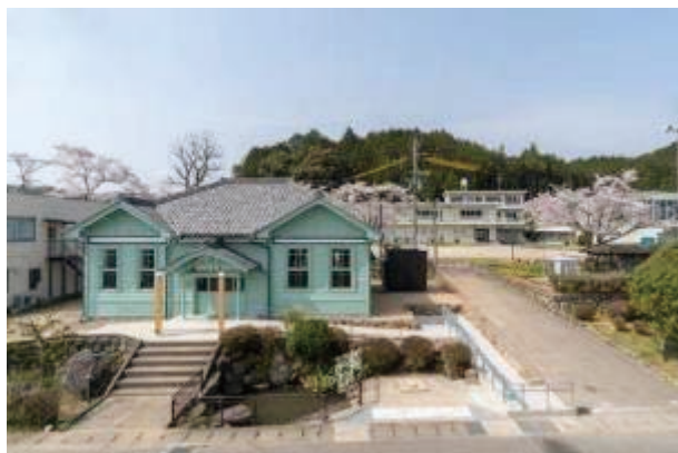
fig.6 改修した役場の外観
