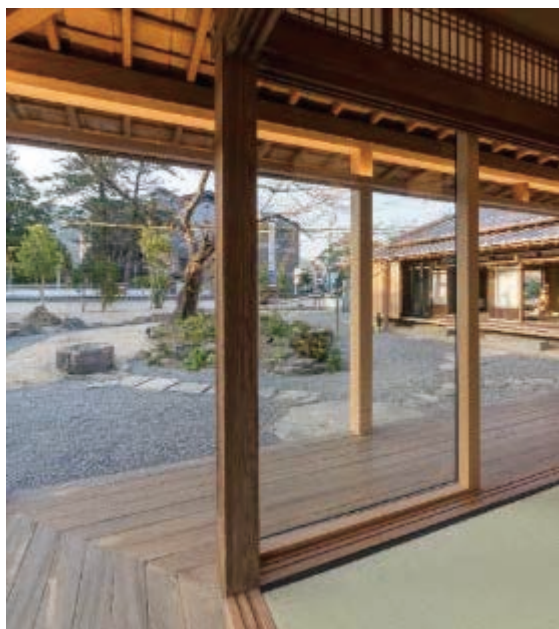
fig.6 : 強化ガラス耐力壁
