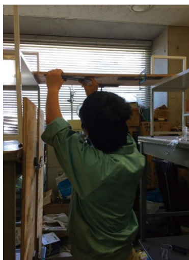
写真2 接着剤接合部の施工試験
