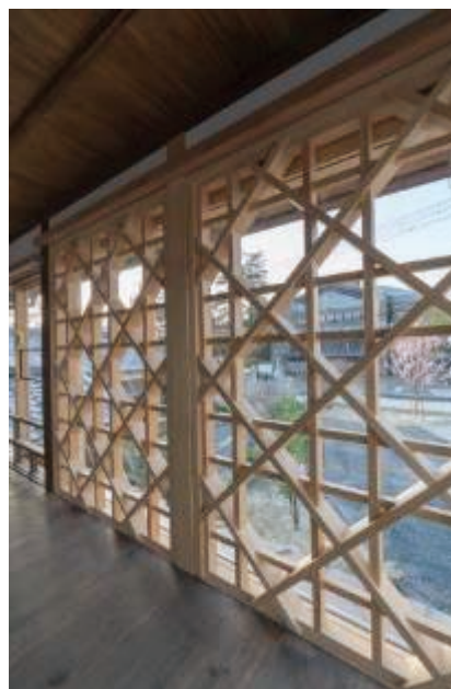
fig.7 : 組子細工耐力壁（古谷誠章研究室 撮影）
