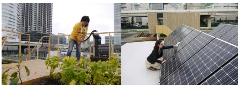
写真2 屋上には家庭菜園と雨水利用の為に手押しポンプ。太陽電池、太陽熱温水器を設置。住まい手が汚れを拭いたりメンテナンスできるように、動線を確保している。
