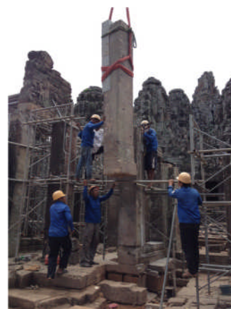
Fig.2 仮組作業現場
