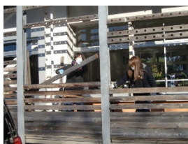
fig.1 ルーバー交換
