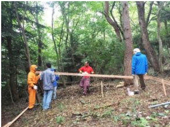
図 7 斜面地における水平出し
