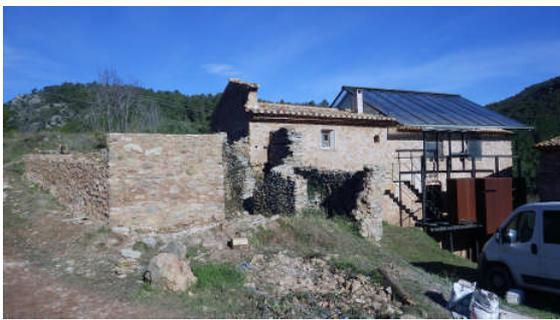
スペイン、カタルーニャ州の伝統的石灰造民家マジアの残存遺構について、タラゴナ県ファッチェス離村集落にある対象遺構A棟について修復・再生を行ってきている。今年度も修復・再生の第三ステージとして、A-3 住戸の西側から南側に至る擁壁的外部壁体の石積み作業を行った。石は崩落した壁体から採取し、バインダーの役割をするアルガマサは現地の粘土を使用し、砂、セメントは市場から調達したものをを使うが、オリジナルに近い制作方法を踏襲している。第三ステージの計画案に沿って、左官工ジュゼップの指導の下、昨年度に記録できた道具類を駆使して、2mに達する壁体を施工することができた。来年度は主要部に取り掛かることになるが、その背景ができたと考えている。
