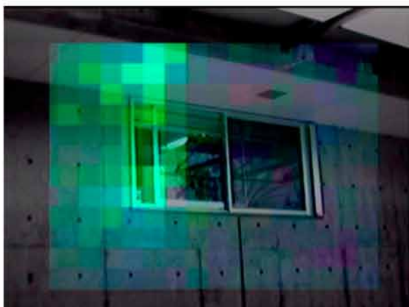
図-3 室内で発生させた白色雑音の窓部漏音
