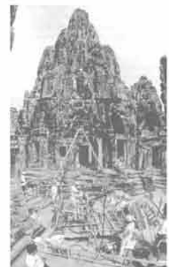
ボーリング調査現場
