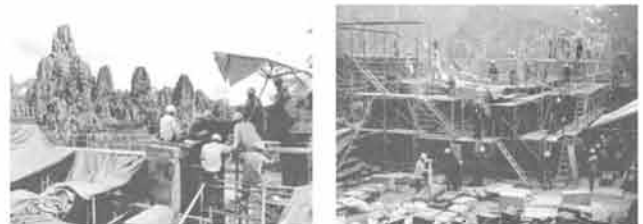
保存修復工事の現場
