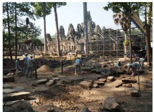
Fig. 2 塔69整備作業の様子
