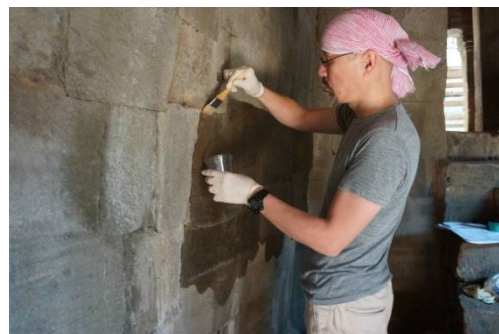
Fig. 3 試験塗布の様子
