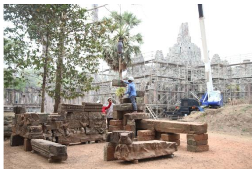
Fig.2 塔69整備作業の様子
