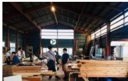
(fig.4) 施工段階の様子
