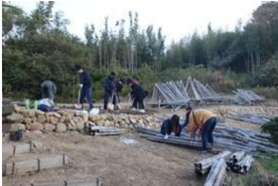
fig.4 竹のシシ垣解体の様子
