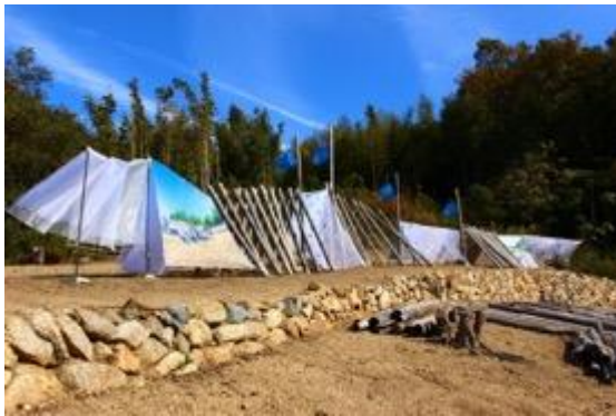
fig.6 解体後、お別れセレモニーに向けて活用
