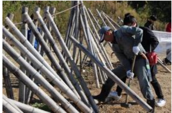
fig.5 竹のシシ垣解体の様子
