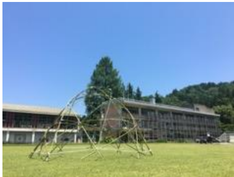
fig.1 細竹を利用したスタードーム
