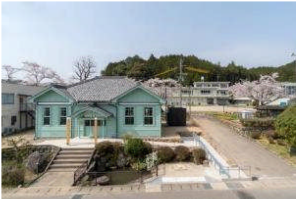
fig.6 改修した役場の外観
