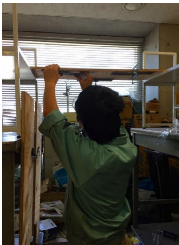
写真2 接着剤接合部の施工試験
