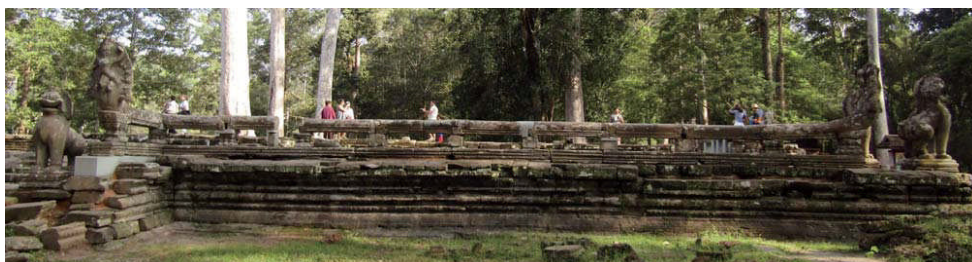
Fig. 5 修復後の参道南東側
