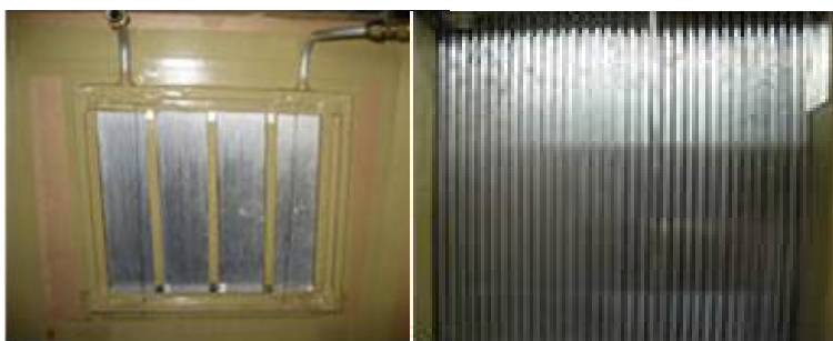
図1 フィンレス熱交換器
