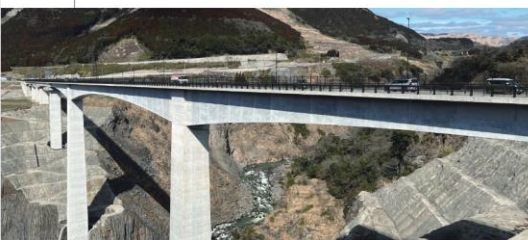
地震時の新居定位、地震後の早期復旧性を考慮して設計された新阿蘇大橋
