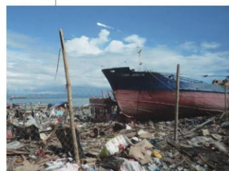
沿岸災害による被害の現地調査
