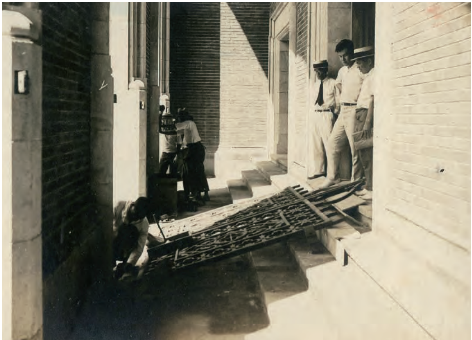
光天井装飾部の工事(上) 門扉の設置(下)
