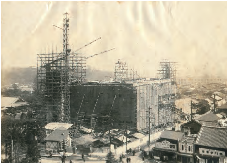
講堂内部の組み立て(上) 講堂全体の形が見えてくる(下)
