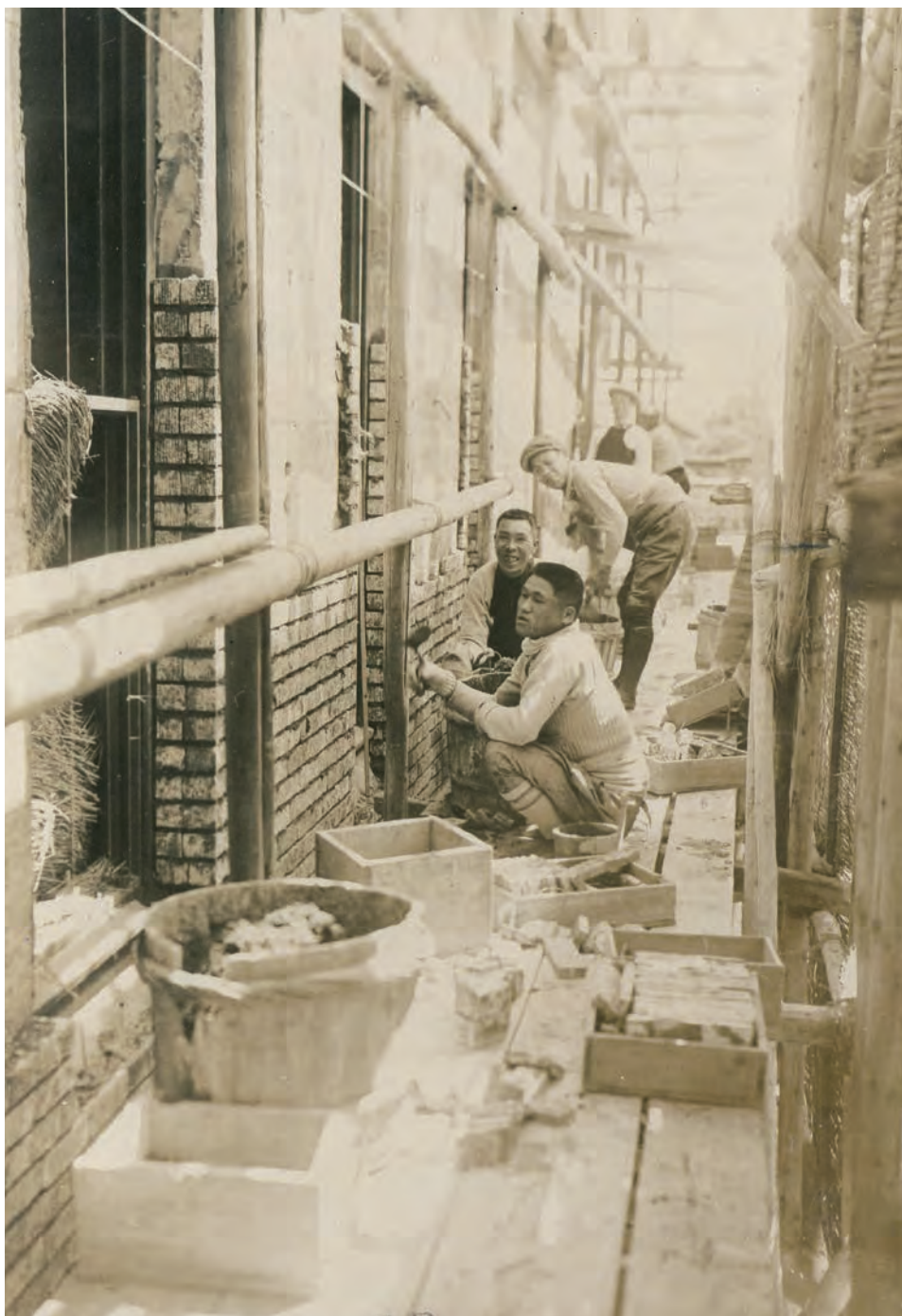
タイルを貼る作業
