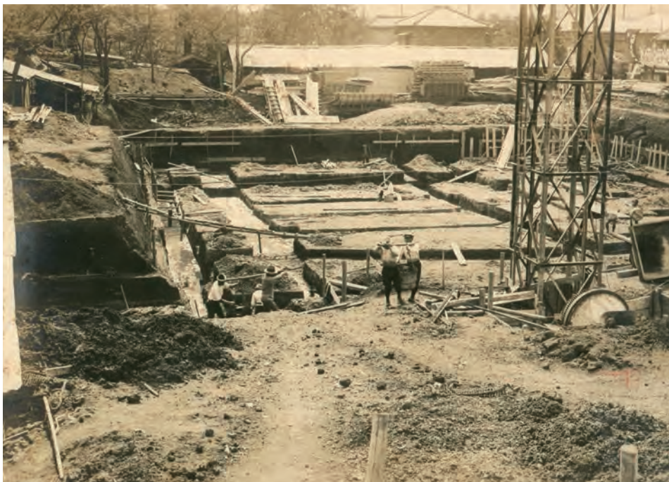
「紀念大講堂工事進行アルバム」1927年 建設地に「故大隈侯爵紀念大講堂建設敷地」という木標がみえる(上) 基礎工事の風景(下)
