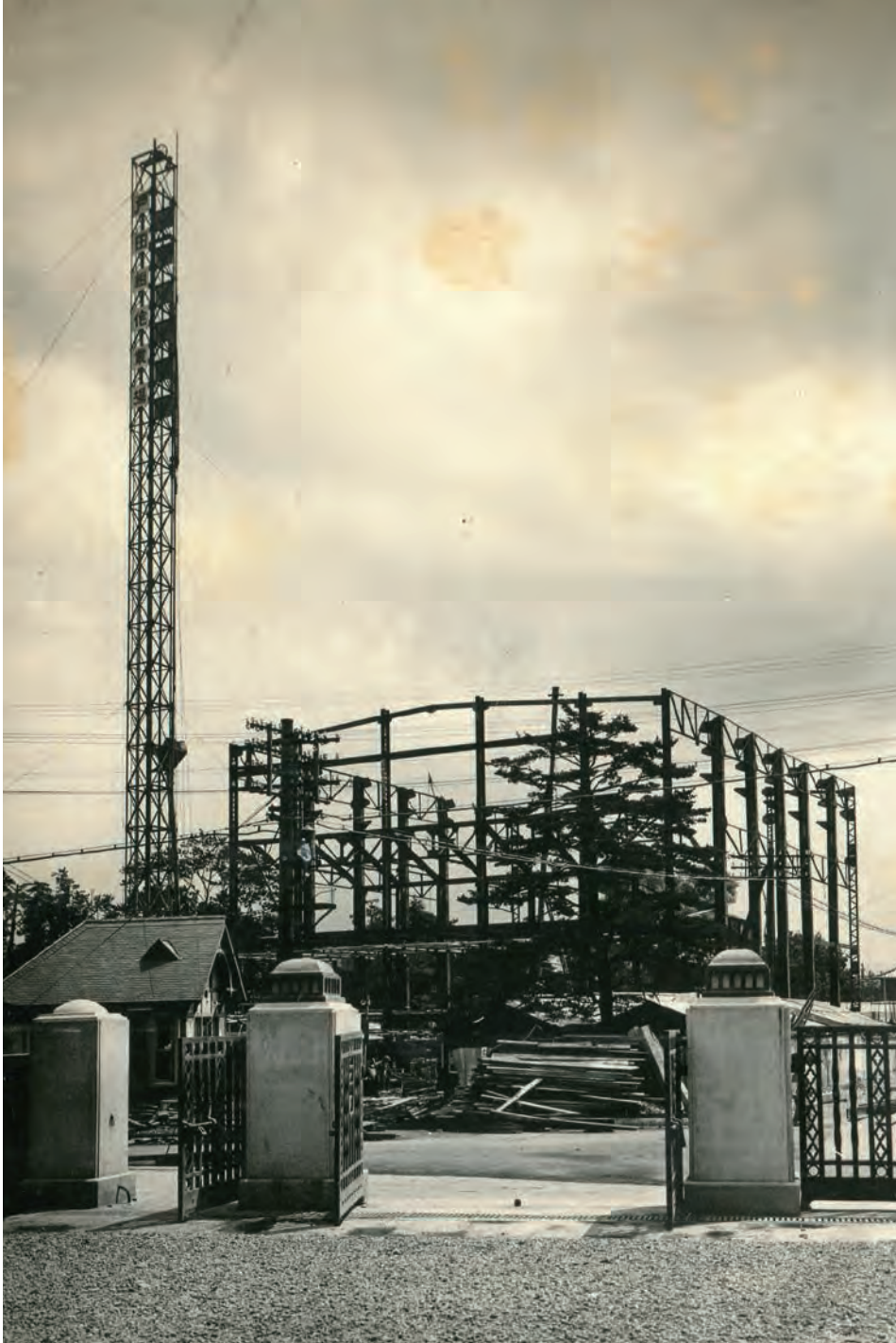
鉄筋の骨組みが姿をあらわす
