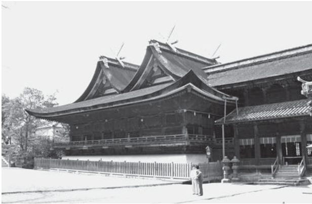
図3. 吉備津神社（岡山市吉備津）。「比翼入母屋造」と呼ばれる独特の構造の屋根を持つ本殿は、室町時代の代表的寺社建築とされる。
