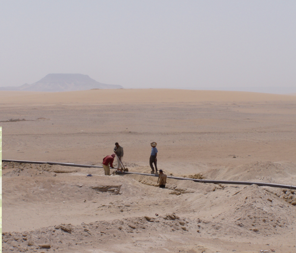
沙漠で住宅用の水道工事をする人たち、ハルガ・オアシス
